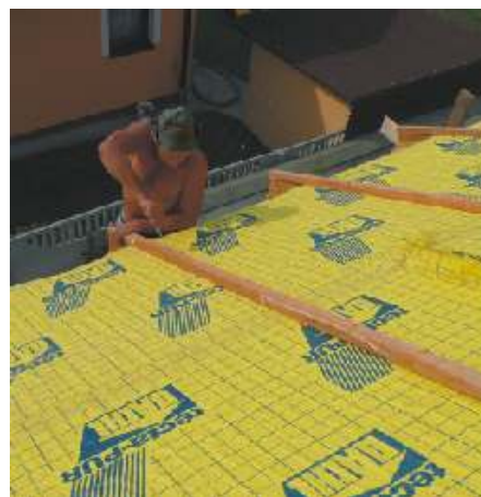
Fot. 5. Układanie termoizolacji na konstrukcji dachowej i mocowanie kontrłat.
